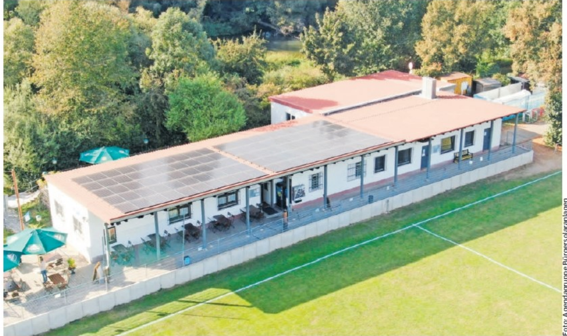
Das Sportheim des TSV Wolkersdorf hat ein recht flach geneigtes Dach. Dennoch „rentiert“ sich die Bürgersolaranlage. Für den Verein, für die Investoren und für die Umwelt.
